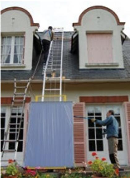
Selon les chantiers, nos monte-matériaux peuvent être utilisés dans différentes configurations : à l'oblique, à la verticale, ou à la verticale puis à l'oblique (en appui sur un toit par exemple).
