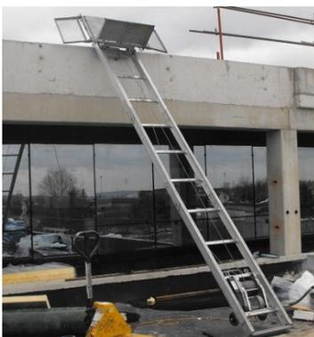
La largeur du chemin de roulement confère à nos monte-matériaux une grande stabilité et permet de monter des charges en toute sécurité.
